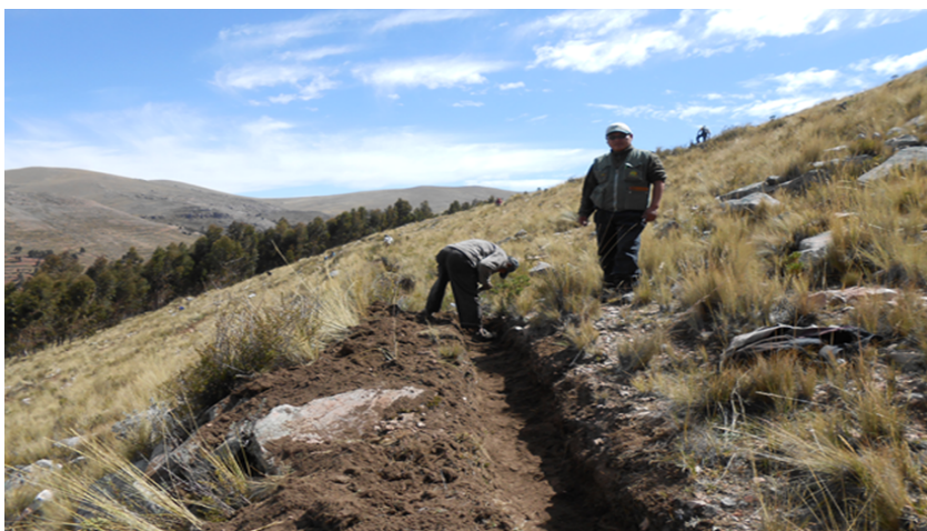
Figura N° 14: Construcción de zanjas de infiltración según pendiente
