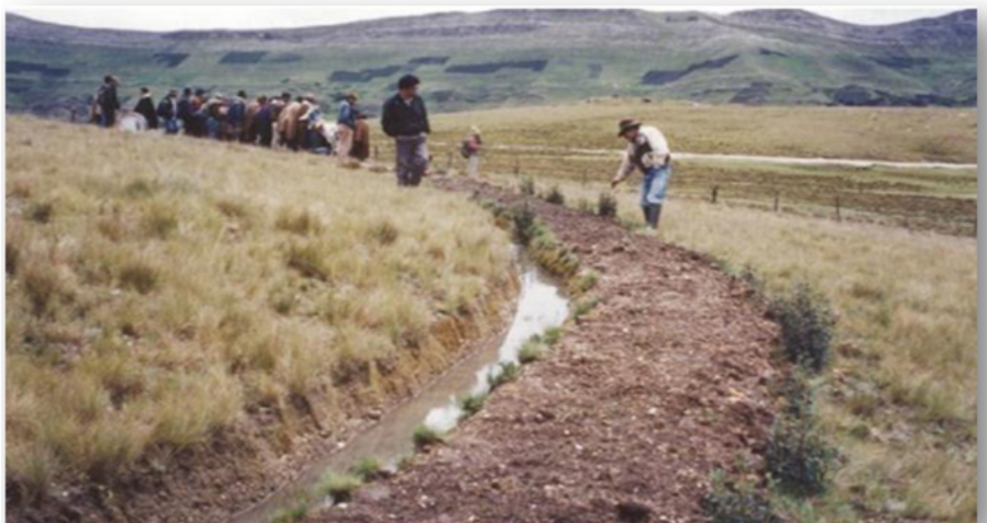
Figura N°22: Zanjas de infiltración asociado con plantaciones forestales queñua Polylepis incana y colle Buddleja coriacea .
